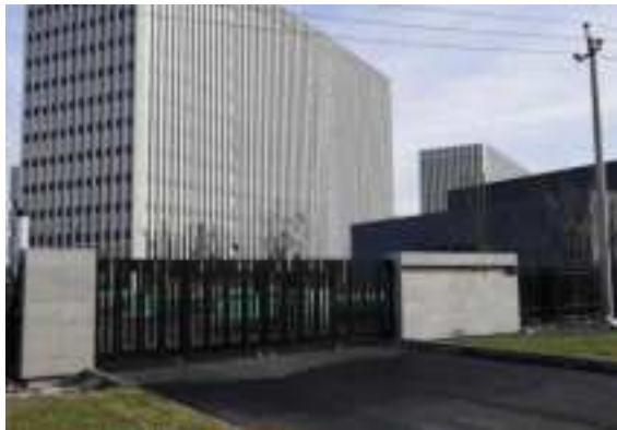
天津华易智诚科技发展有限公司（东侧紧邻）
